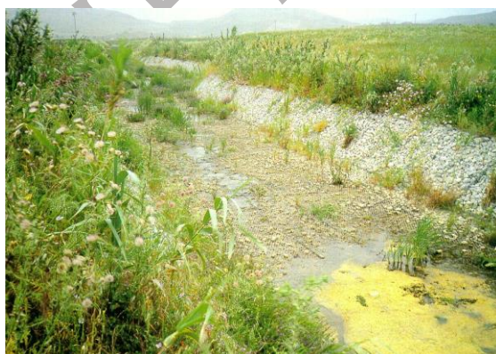
贵州省黔东南州剑河县完工后生态修复
