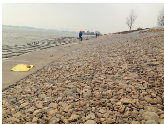
长江入海口堤坝防护工程
